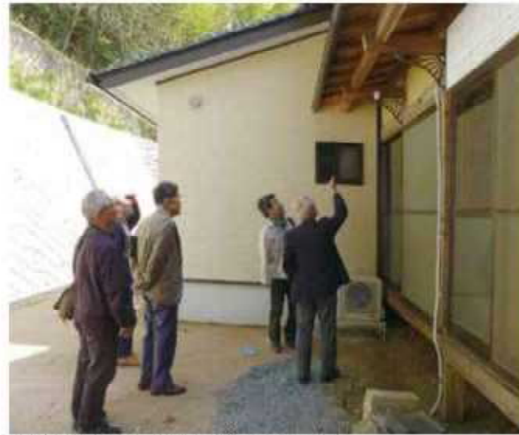
黒山土砂崩れからの一連の工事が全て完了致しました。
