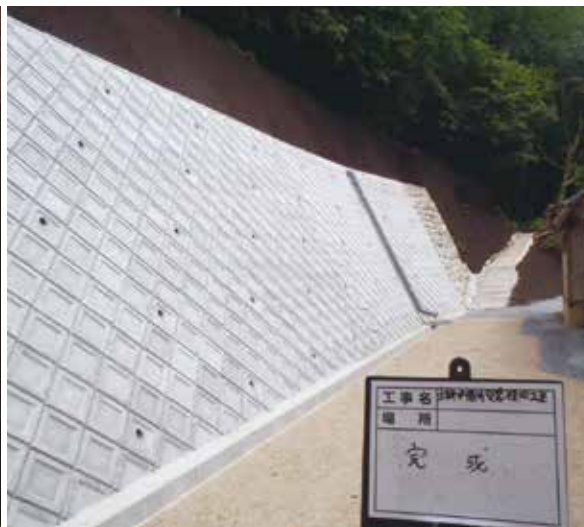
本堂裏擁壁完成写真
