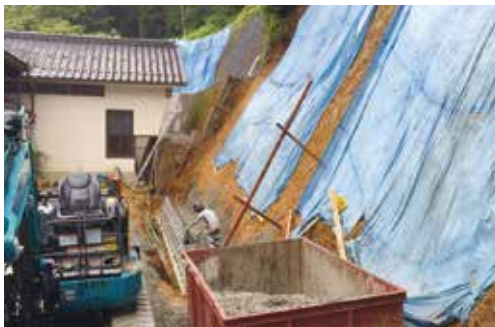
手作業によるブロック積
