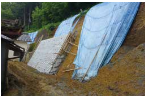
コンクリを流し込みながら積み上げていく
