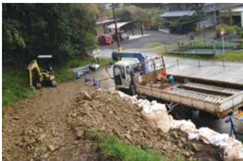
第二駐車場から搬入路の建設
