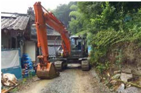
山小屋を解体後搬入路を確保
